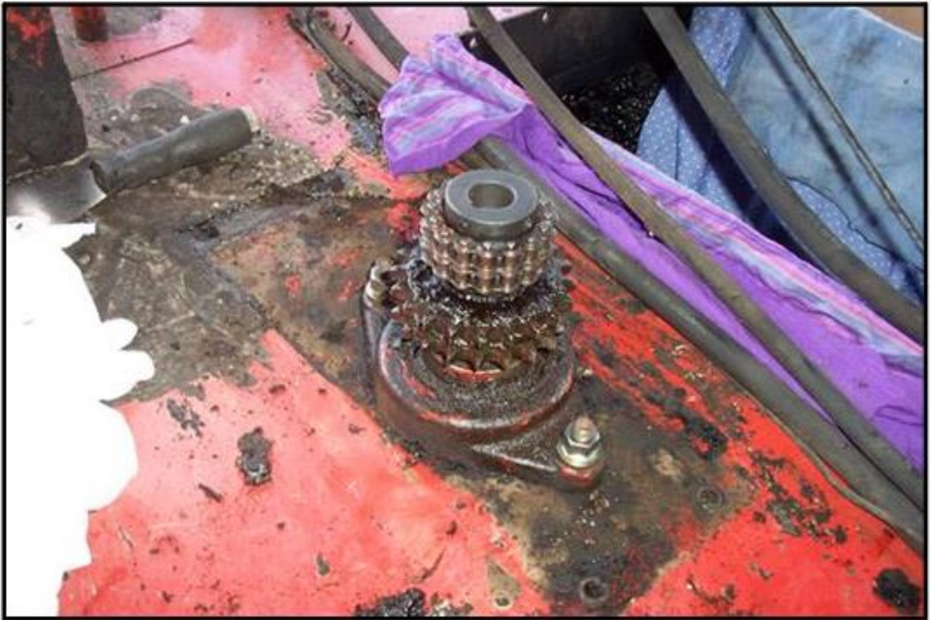
图 6.11 材料泵驱动轴的更换
