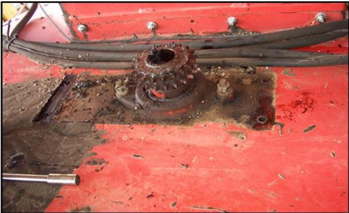
图 6.4 拆下液压马达安装架
